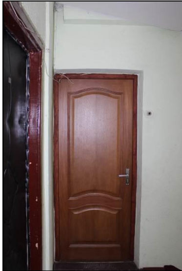
Kāpņu telpas (dzīvokļa ārdurvis)
